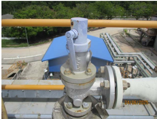
รูปที่ 3.1-1 (รูปที่ 67 Safety Valve (Relief & Vacuum Valve และ Shutoff Valve))
