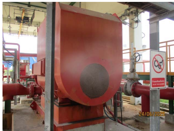
รูปที่ 3.1-1 (รูปที่ 63 Electric Fire Pump)
