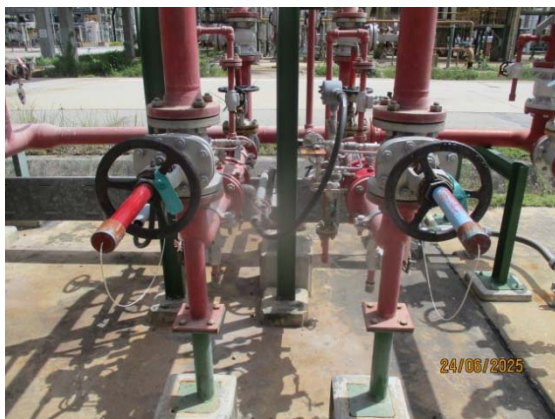
รูปที่ 3.1-1 (รูปที่ 53 Deluge Valve System)
