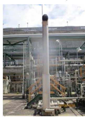
รูปที่ 3.1-1 (รูปที่ 42) การติดตั้ง Silencer บริเวณ Line Steam Vent ของระบบหล่อเย็น)
