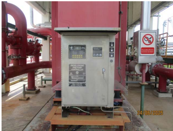
รูปที่ 3.1-1 (รูปที่ 61 Diesel Fire Pump)
