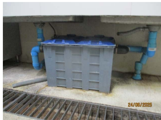
รูปที่ 3.1-1 (รูปที่ 18 ถังดักไขมันที่โรงอาหาร)
