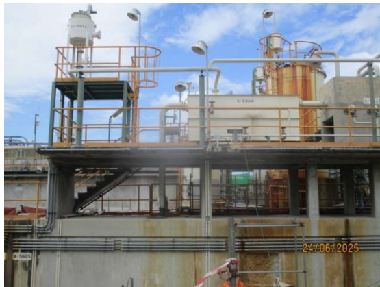
รูปที่ 3.1-1 (รูปที่ 7 ถังแยกน้ำมันแบบ CPI Oil Separator)
