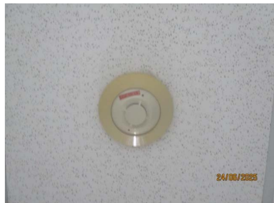
รูปที่ 3.1-1 (รูปที่ 24 Heat Detector)
