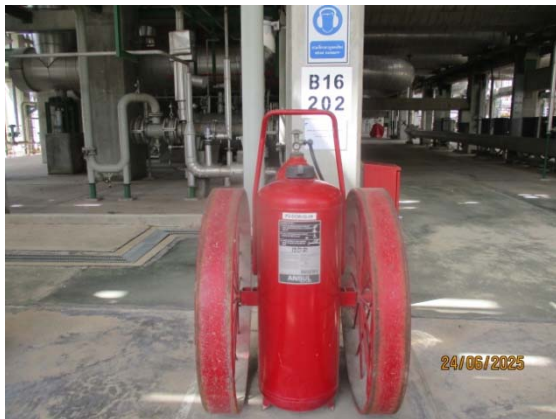
รูปที่ 3.1-1 (รูปที่ 55 Wheeled Fire Extinguisher)
