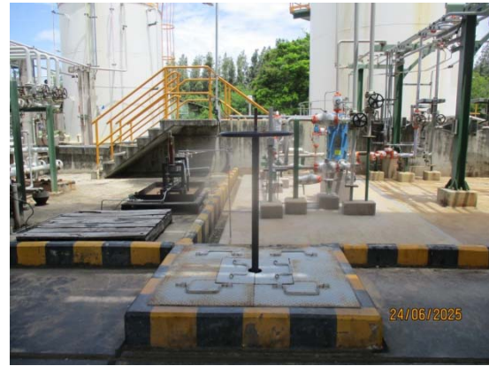
รูปที่ 3.1-1 (รูปที่ 68 วาล์วตัดแยกกระบวน)
