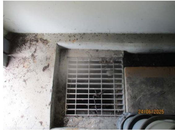
รูปที่ 3.1-1 (รูปที่ 20 บ่อรวบรวมน้ำเสียที่หกั่วไหลจากอาคารเก็บกากของเสีย)
