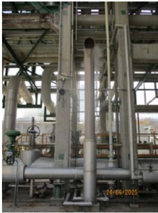
รูปที่ 3.1-1 (รูปที่ 43) การติดตั้ง Silencer บริเวณ Safety Valve ของท่อส่งน้ำที่ส่งกลับไปยังบริษัท พีทีที โกลบอล เพาเวอร์ ซินเนอร์ยี จำกัด
