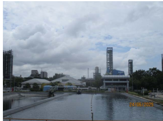
รูปที่ 3.1-1 (รูปที่ 14 บ่อพักน้ำทิ้งขนาด 4,000 ลบ.ม.)
