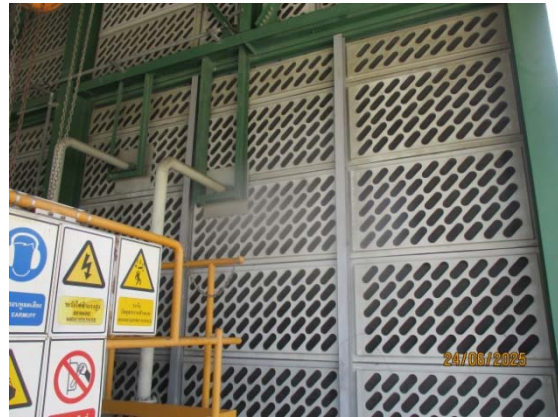
รูปที่ 3.1-1 (รูปที่ 44) การติดตั้งผนังกันเสียง บริเวณ Decoke Air Compressor)
