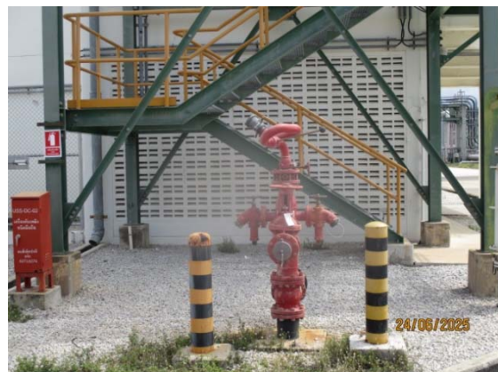
รูปที่ 3.1-1 (รูปที่ 56 Water Hydrants (Indoor & Outdoor))
