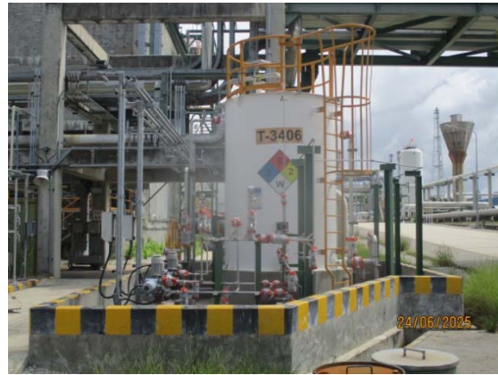
รูปที่ 3.1-1 (รูปที่ 46) คันคอนกรีตล้อมรอบถังกักเก็บสารเคมี)
