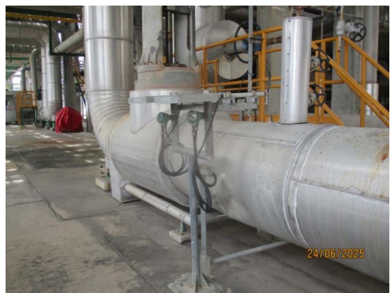
รูปที่ 3.1-1 (รูปที่ 28 ติดตั้งวัสดุดูดซับเสียง)
