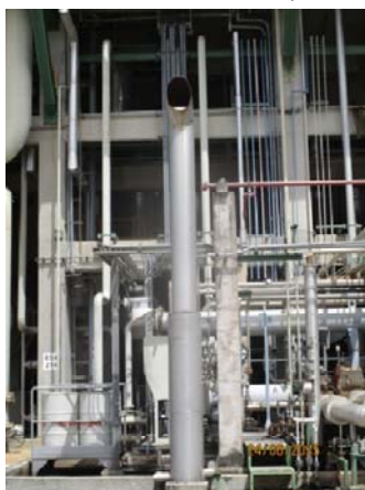
รูปที่ 3.1-1 (รูปที่ 41) การติดตั้ง Silencer บริเวณ Change Gas Compressor)
