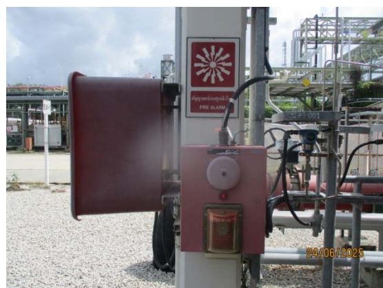
รูปที่ 3.1-1 (รูปที่ 59 Manual Fire Alarm)
