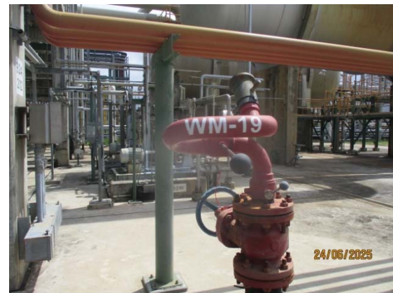
รูปที่ 3.1-1 (รูปที่ 52 Water Hydrants with Monitors)
