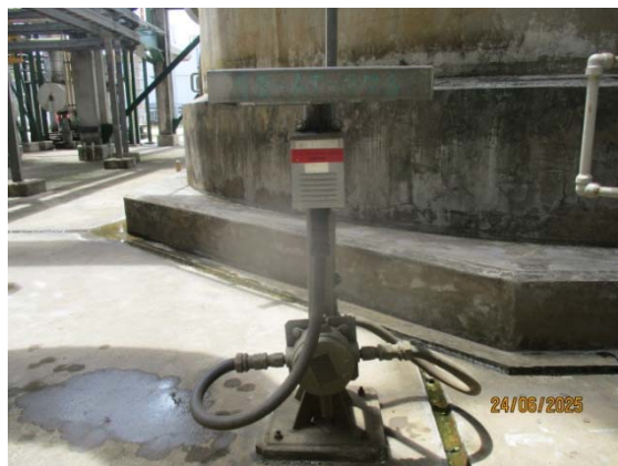
รูปที่ 3.1-1 (รูปที่ 48) Fixed Gas Detector)
