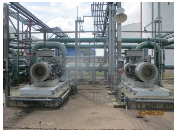
รูปที่ 3.1-1 (รูปที่ 64 Electric Jockey Pump)
